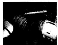
写真 4 送風機による換気
